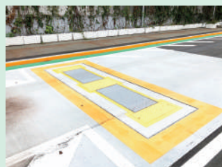
▲ オレンジで囲われた部分がトラック用輪重計です。設置するにあたり、床面が平らでないと正確に測定することができないので、コンテナホームを一部掘り下げ、勾配をなくしています。
